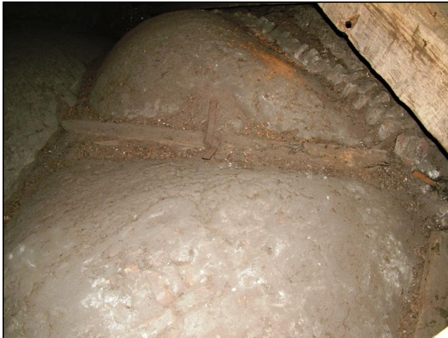
Bij de dekbalk in het schip waarin het "touwgat" voorkomt (zie Bijzonderheden 4), zijn de gewelfribben versterkt met hout.
