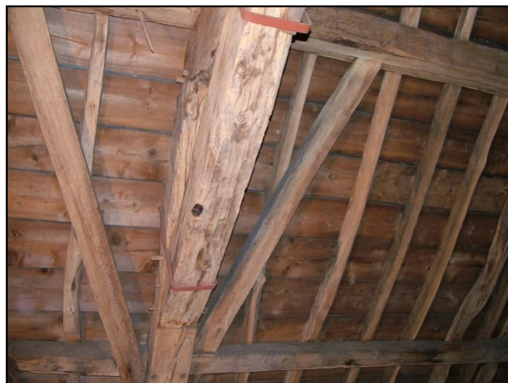
Op het eikenhouten korbeel van het 5 e spant boven het schip van de kerk is de ring geslagen waardoor geboord zal worden.
