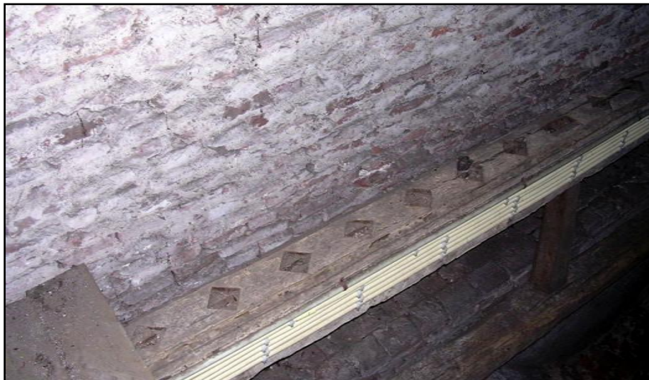
De hergebruikte balk tegen de westmuur van het koor; foto Wies van Leeuwen.
