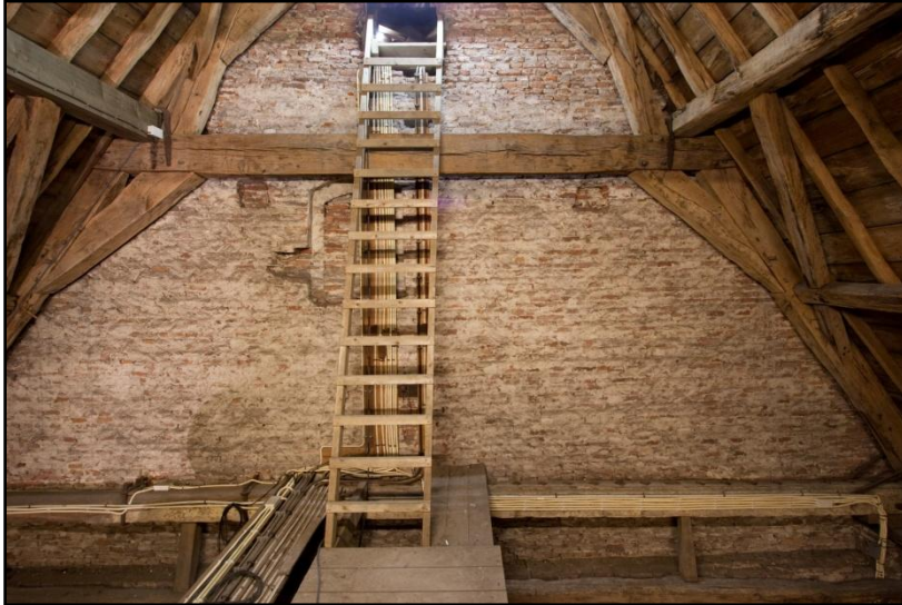
Links en rechts van de ladder zitten in de westgevel van het koor uitsparingen van onbekende functie. Bovenaan de ladder de huidige doorgang van koor naar schip; achter de ladder de dichtgezette doorgang van koor naar oude kapel.
