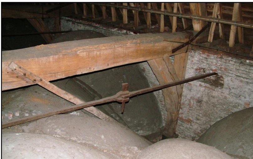
Een van de vroeg-19 e eeuwse trekstangen over de gewelven van het schip.
