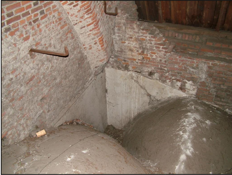
De andere zijde van de grote boog met de engeltjes toont eveneens de bepleistering van de muren onder het houten gewelf van de zijbeuk. In de haken hing de nokbalk van het dak van de zijbeuk, dat hier ter plaatse van het transept is verwijderd. De gewelven dateren uit 1926.
