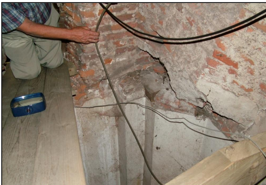
Op deze foto is de bepleistering zichtbaar die aangebracht was op de grote zuidelijke kolom van de viering en die zichtbaar was, tot 1926, onder het houten gewelf van de 5 e travee van de zuidelijke zijbeuk. De bovenzijde van de pleister markeert de plaats van het houten gewelf. Rechtsboven de aanzet van de grote boog met de engeltjes.
