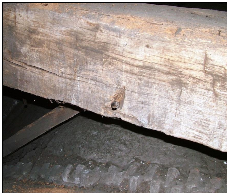
De opening in onderslagbalk II van het schip. Geheel onder een rib in de gewelven.
