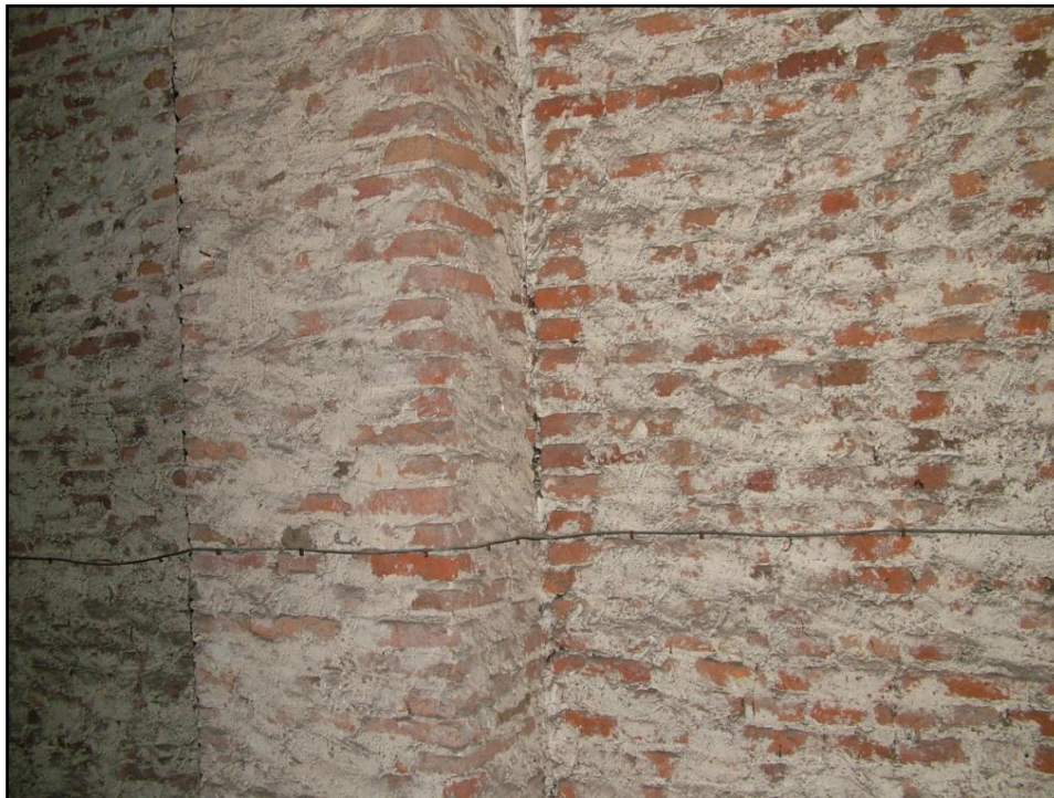
In het midden van de afbeelding, van boven naar beneden, loopt de koude naad in de 4 e travee van de zuidelijke arcade.
