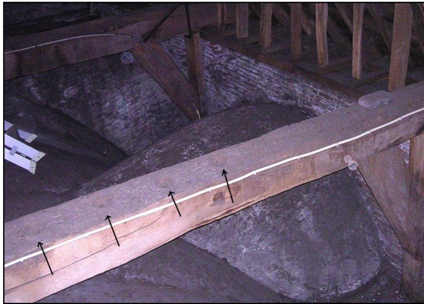
De 4 komvormige uithollingen (pijlen) op de onderslagbalk van het derde spant in het koor.
