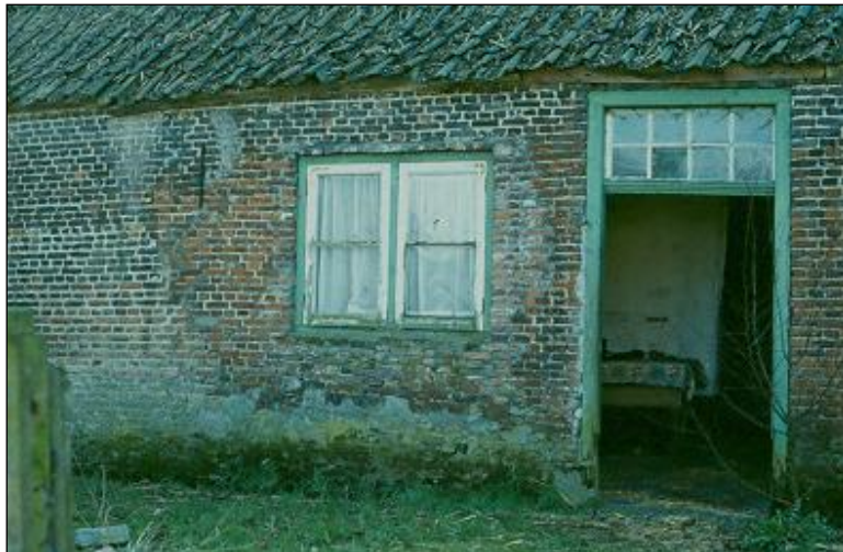
Dit is de deur in de noordelijke zijgevel die in de geut komt. Het afwijkende metselwerk linksonder is van de kelder (dia 294).
