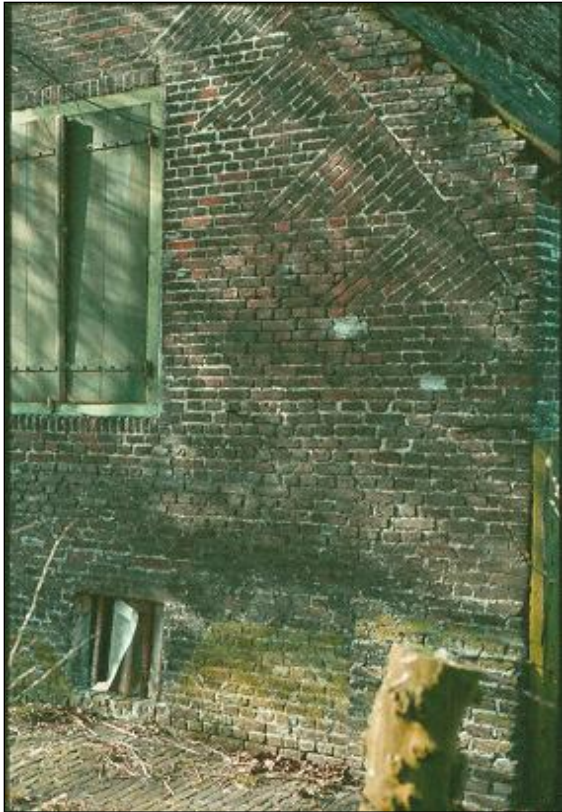
Het "nieuwe" kelderraam in de voorgevel met rechts daarvan de steunbeer (dia 282).
