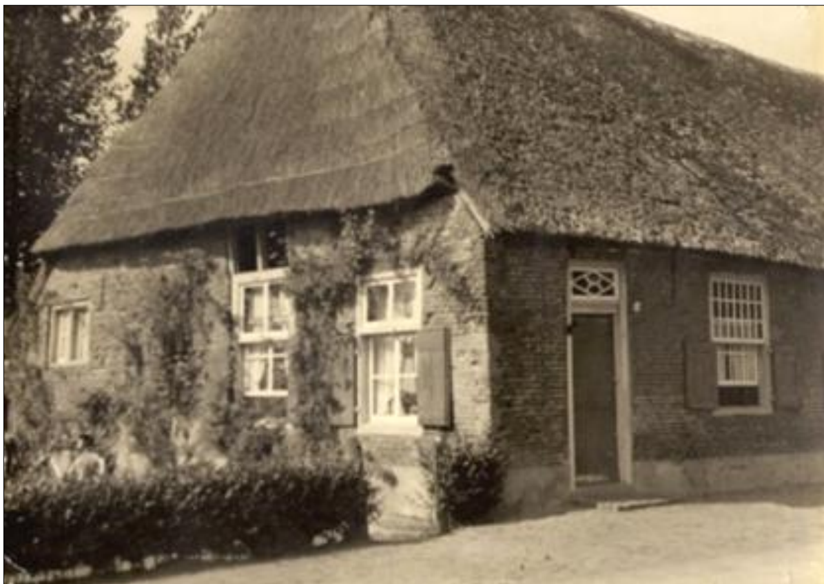
Boschpad A 28, afgebroken in 1956 . Ons huis stond heel dicht aan de weg. Een dak van stro. Tijdens de ker- misdagen was de brandweer paraat. Een brandweerwagen stond tegenover ons bij Oerlemans steeds paraat. Let op de indeling van het rechter raam, de halve vensters, het bovenlicht boven de deur, het vlechtwerk in de linker gevel en het huisnummer A28.
