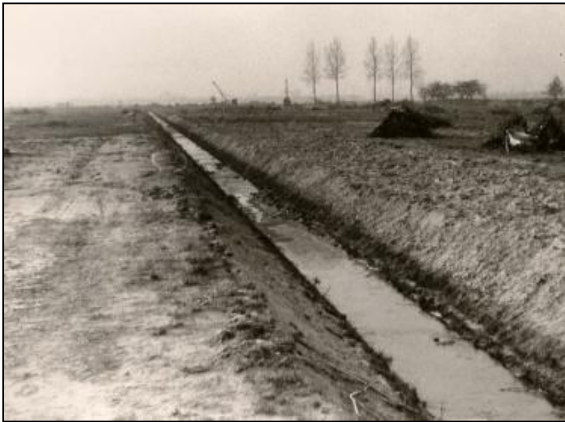
Werkzaamheden in het Waterstraatje (Spurkstraat) in november 1963. (foto LvM 556b)
