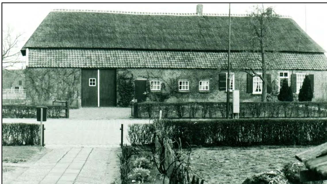
De zijgevel heeft het duidelijke kenmerk van een 19 e eeuwse boerderij. In Den Dungen bouwde men dit type niet voor die tijd. De voordeur zit rechts, en niet in de korte gevel rechts om de hoek. Rechts het woongedeelte, links het bedrijfsdeel met stal en schuur. Foto EV1550, uit 1983.
