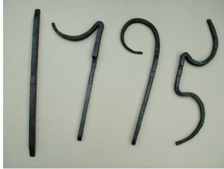
De ankers van de voorgevel van Litsestraat 52.
