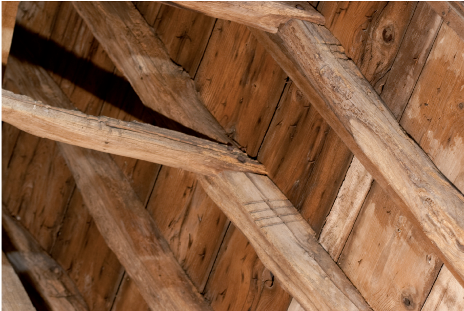
Afbeelding 30d: Sporen in de kap van het koor met gezaagde merken III en IIII.
