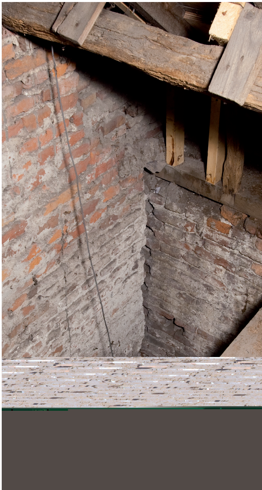
Afbeelding 15: De muur tussen transept en zuidelijke zijbeuk (links) is niet in verband gemetseld met de gevel van de zuidbeuk (rechts). Dit duidt doorgaans op een bouwfase.
