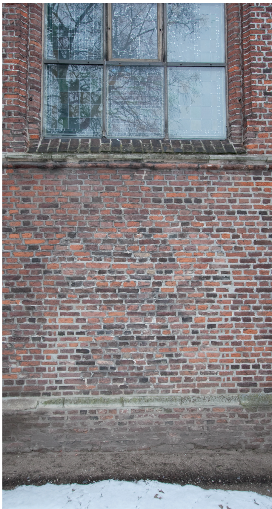
Afbeelding 6: In de zuidbeuk tekent zich een dichtgezette toegang af, welke op basis van de nog bestaande klezoren, vermoedelijk oorspronkelijk was.
