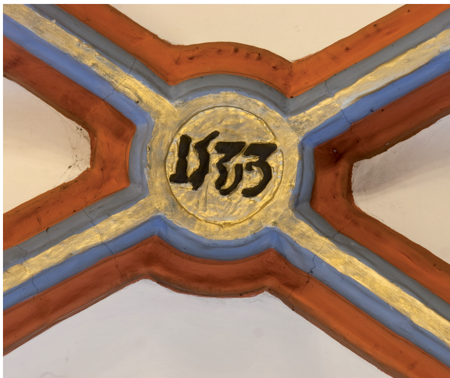
Afbeelding 25: Een sluitsteen in één van de gewelven in de zuidelijke zuidbeuk geeft het jaartal 1533 weer. Dit jaartal duidt vermoedelijk op de voltooiing van de gewelven. De gewelven werden doorgaans als laatste geslagen, nadat de muren van het gebouw enkele jaren tijd hadden gekregen om te 'zetten'. Daarmee wordt bedoeld dat de mortel waarmee was gemetseld voldoende was gehard zodat de muren de spatkrachten van de gewelven voldoende naar het fundament af konden leiden.
