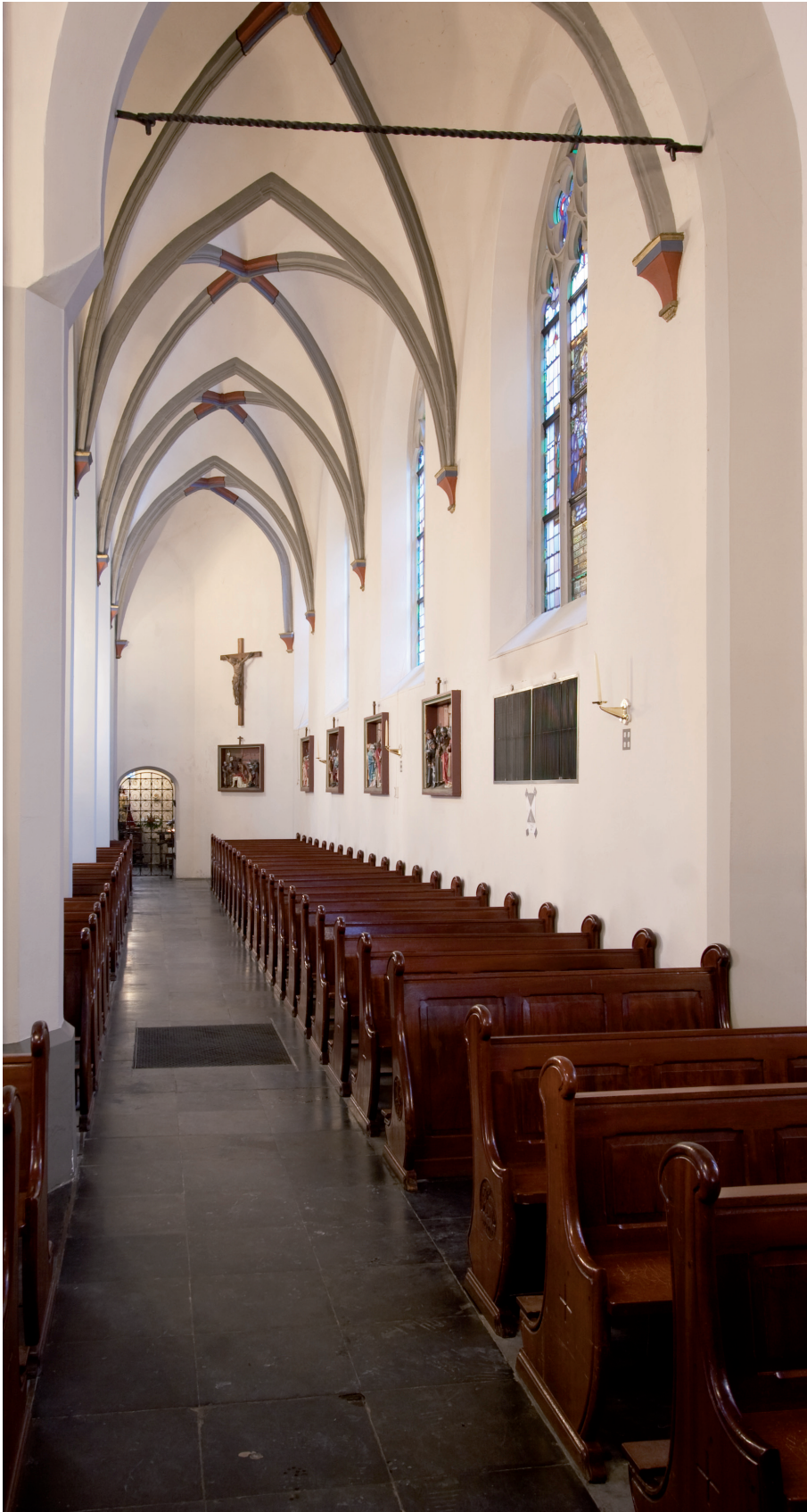
Afbeelding 20: De ribgewelven in de noordelijke zijbeuk. De wat curieuze aansluiting van de scheiboog op de voorste kolom lijkt niet oorspronkelijk.
