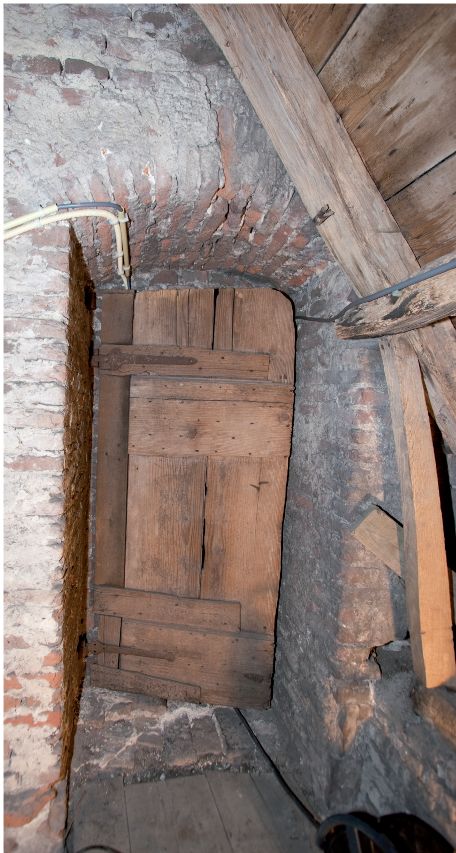
Afbeelding 17d: De doorgang en deur van de traptoren naar de kap van de zuidelijke zijbeuk.
