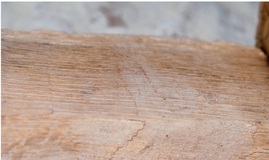
Afbeelding 40: Telmerken in rood krijt, aangetroffen op de spanten in de noordelijke zijbeuk.
