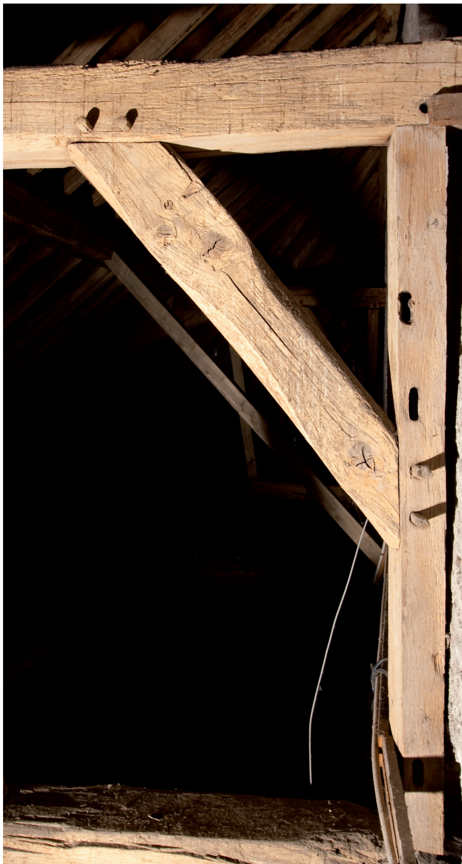
Afbeelding 38: De muurstijl van het meest oostelijke spant in de zuidelijke zijbeuk met daarin drie ovaaltjes die door geboord zijn.
