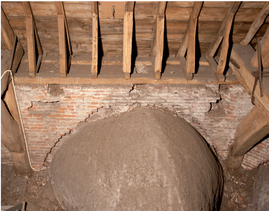
Afbeelding 17e: De noordmuur van het koor heeft boven de gewelven behoudens de gebruikelijke kortelinggaten die de gehele muurdikte doorbreken, ook nog gaten die minder diep zijn. Mogelijk dienden deze voor balken van een werkvloer. Op de foto is verder te zien dat de gewelfsleuven zijn uitgespaard en dat de sleuven na het slaan van de gewelven niet zijn opgevuld (zoals later in het schip zou gebeuren).
