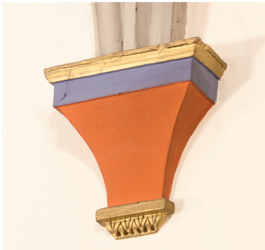
Afbeelding 21: Eén van de vermoedelijk in 1821 aangebrachte consoles onder de ribgeboorte van de gewelven in de zijbeuken.
