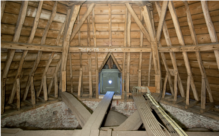
Afbeelding 29: De koorsluiting in de kap, waar twee halve spanten op een gevorkte onderslagconstructie zonder korbeels en muurstijlen zijn geplaatst.
