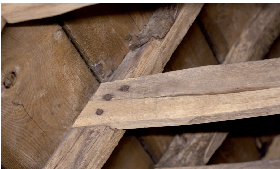
Afbeelding 30a: Gespijkerde haanhouten in de kap van het koor, hier met het merk VII (gebroken merktekens).
