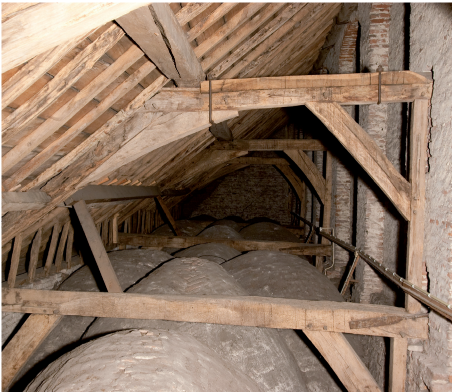
Afbeelding 37: Het vanuit het westen gezien tweede spant in de noordelijke zijbeuk.
