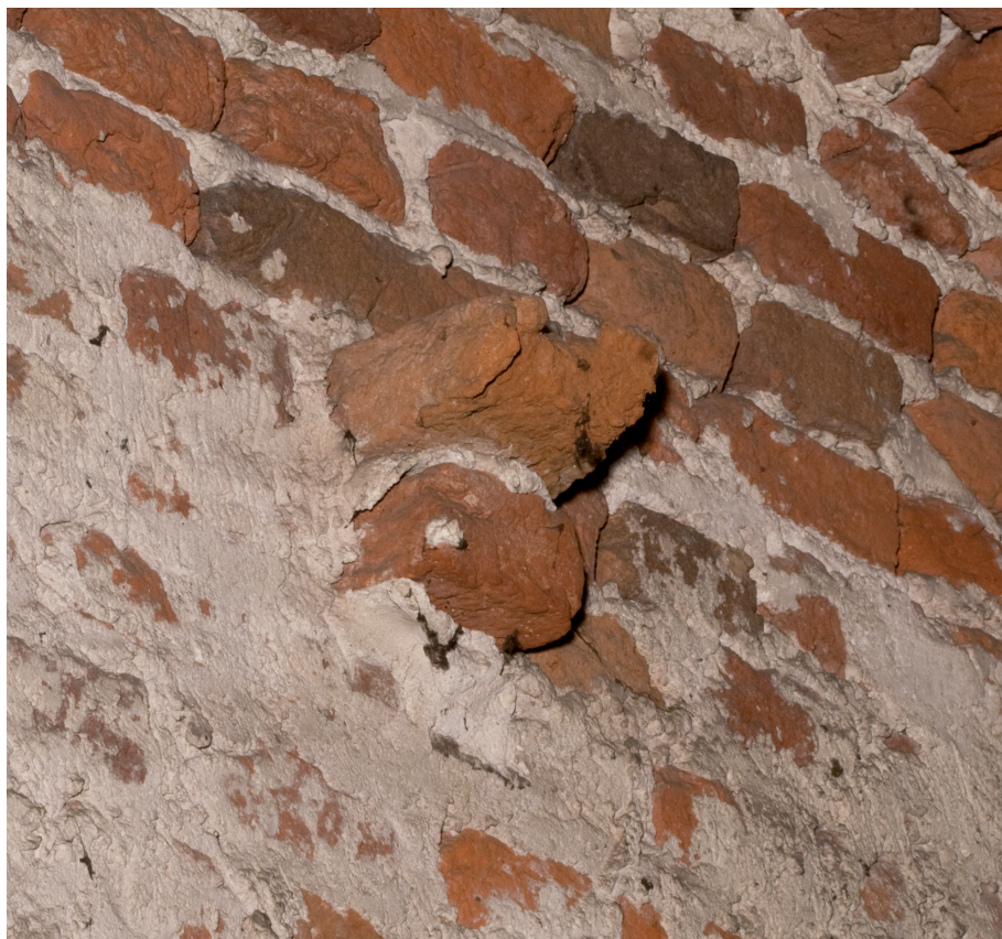
Afbeelding 17: Een resterende console waarop het formeel rustte. In de boog zijn speciebaarden te zien, welke ook op het gebruik van een formeel wijzen.
