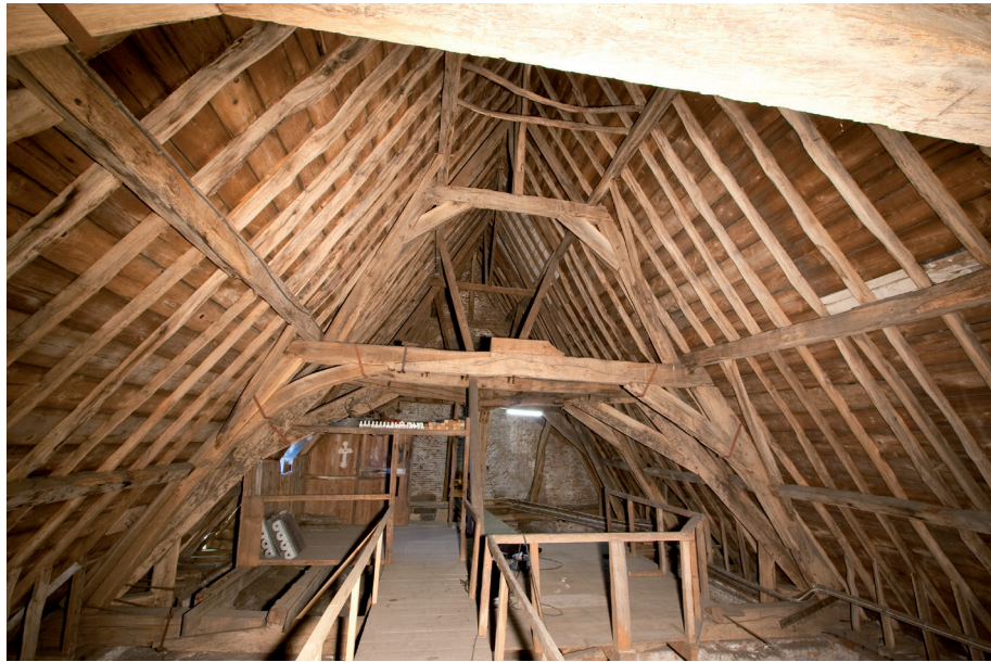
Afbeelding 31: Overzichtsfoto van de kapconstructie van het schip, hier met een blik in de viering. Op de bovenste flieringen zijn op enkele plaatsen nog rondhouten aanwezig.
