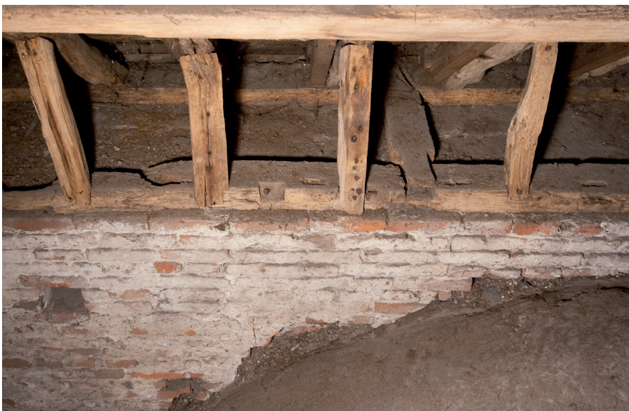
Afbeelding 41: Op sommige plekken is de muurplaat nog oorspronkelijk. In deze muurplaat zijn de inkepingen te zien waar de oorspronkelijke standzonen ingestoken zijn geweest. Alle standzonen die tegen de muurplaat zijn gezet, zijn vernieuwingen. Op de foto is ook te zien hoe de beide muurplaten met elkaar in verbinding zijn gebracht. Dit gebeurde met de vrij gebruikelijke zwaluwstaartverbinding.
