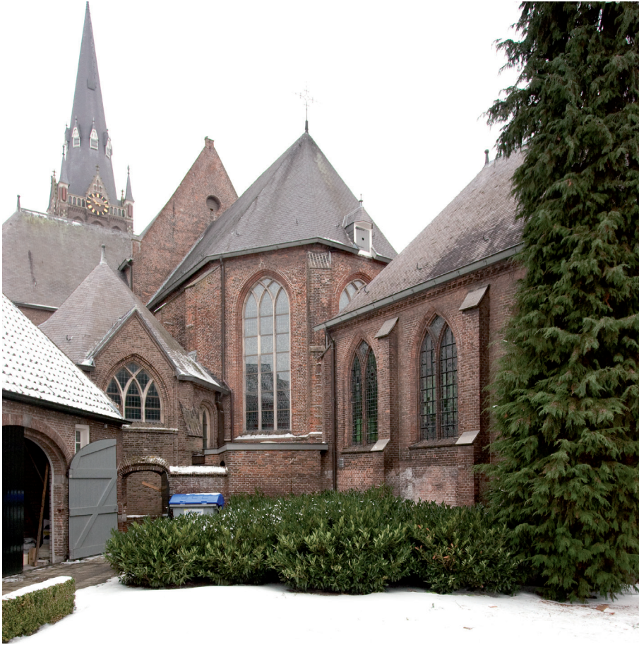
Afbeelding 9: Overzicht van het koor dat deels is ingesloten door negentiende- en twintigste-eeuwse aanbouwen. Tevens de als tuitgevel uitgevoerde kopgevel van het schip.
