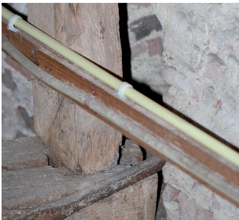
Afbeelding 17a: De muur aan de noordzijde heeft ter plaatse van de oplegging van de kasspanen van de zuidelijke zijbeuk uitsparingen onder een keperboog. Deze ontbreken aan de noordzijde, wat duidt op een bouwphase.
