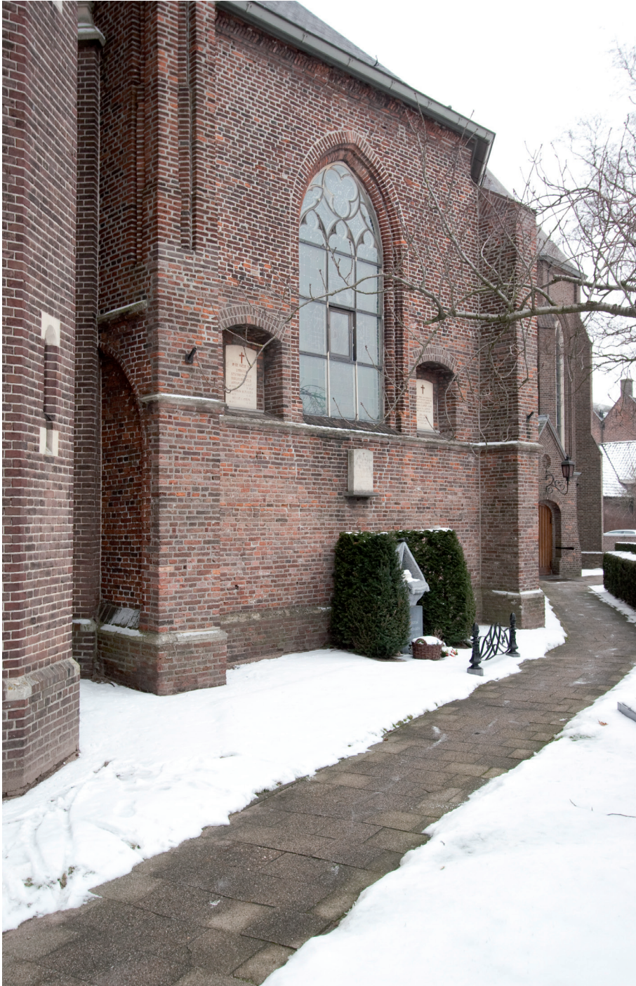
Afbeelding 5: Schuine zijde van de zuidbeuk. Het onderste deel van het zichtbare metselwerk is aangepast en vernieuwd. De linker steunbeer heeft op de toren uit 1899 gericht een spitsgebogen spaarveld onder een waterlijst.
