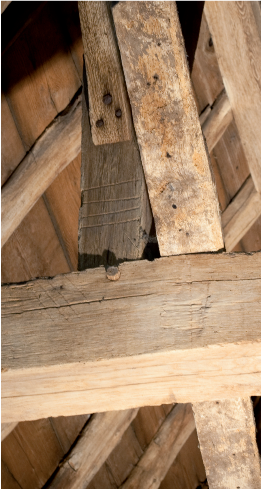
Afbeelding 33: Telmerken op een nokstijl en de bovenste dekbalk van de kap van het schip.
