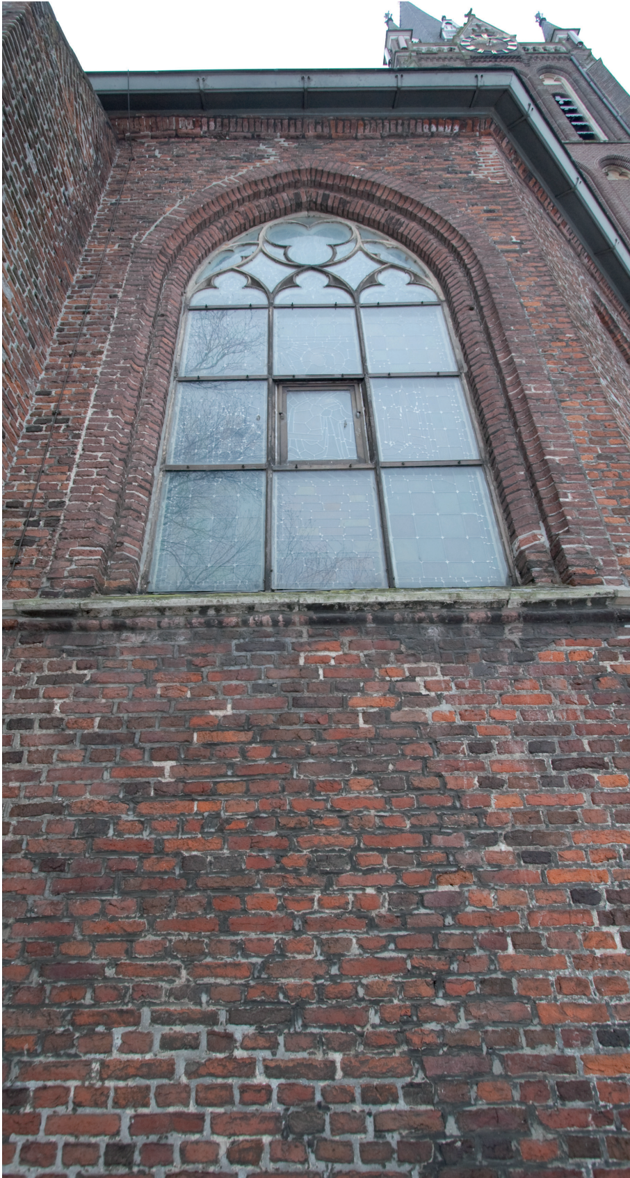
Afbeelding 7: In de eerste travee van de noordbeuk is een vensteropening toegevoegd.
