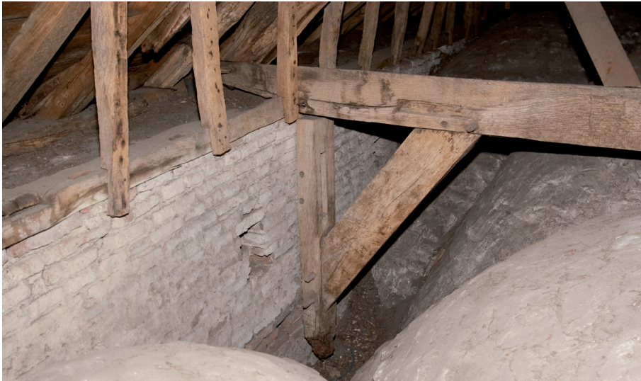
Afbeelding 39: In de kapconstructie van de noordelijke zijbeuk is heel wat hout hergebruikt, zoals hier de muurstijl met een ongebruikte inkeping. In de dekbalk is ook een inkeping te ontdekken.
