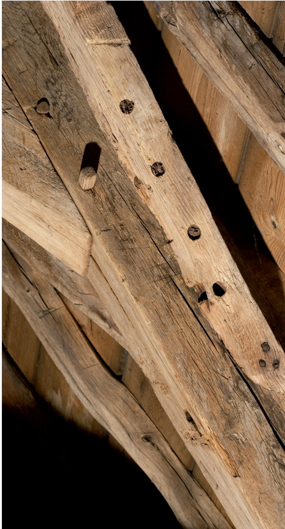
Afbeelding 34: Overduidelijk sporen van hergebruik op één van de windverbanden in het schip. In de kappen van zowel het koor als het schip en de zijbeuken is sprake van enig hergebruik van bouw materiaal.
