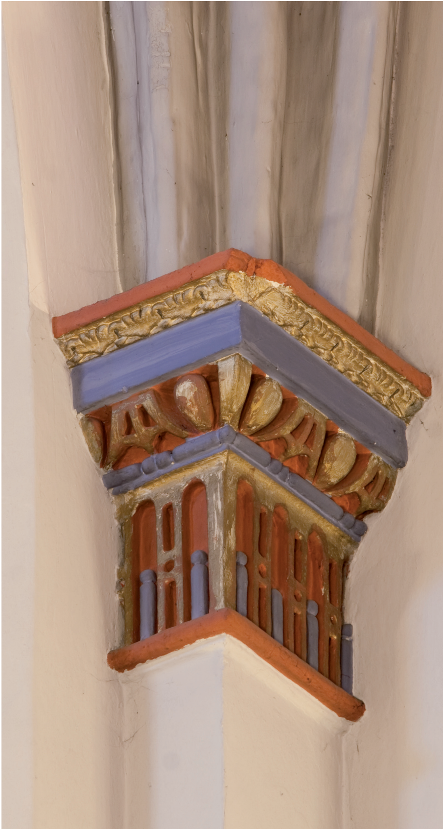
Afbeelding 23: Eén van de vermoedelijk in 1821 aangebrachte consoles onder de ribgeboorte van het vieringewelf.
