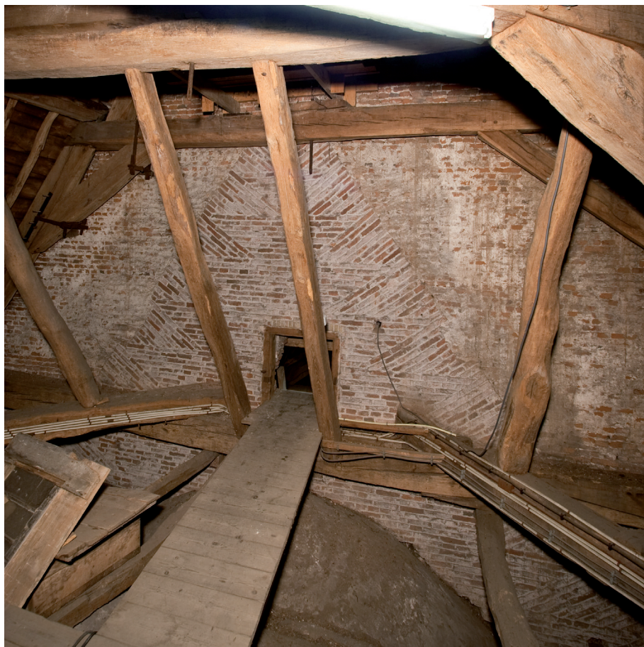
Afbeelding 11: De muur tussen het koor en het schip, gezien vanuit het schip. Op de foto een ingehakte gewelfsleuf, een toegevoegde luikopening en oorspronkelijke vlechtingen van de inpandig geraakte voorgevel van het huidige koor.
