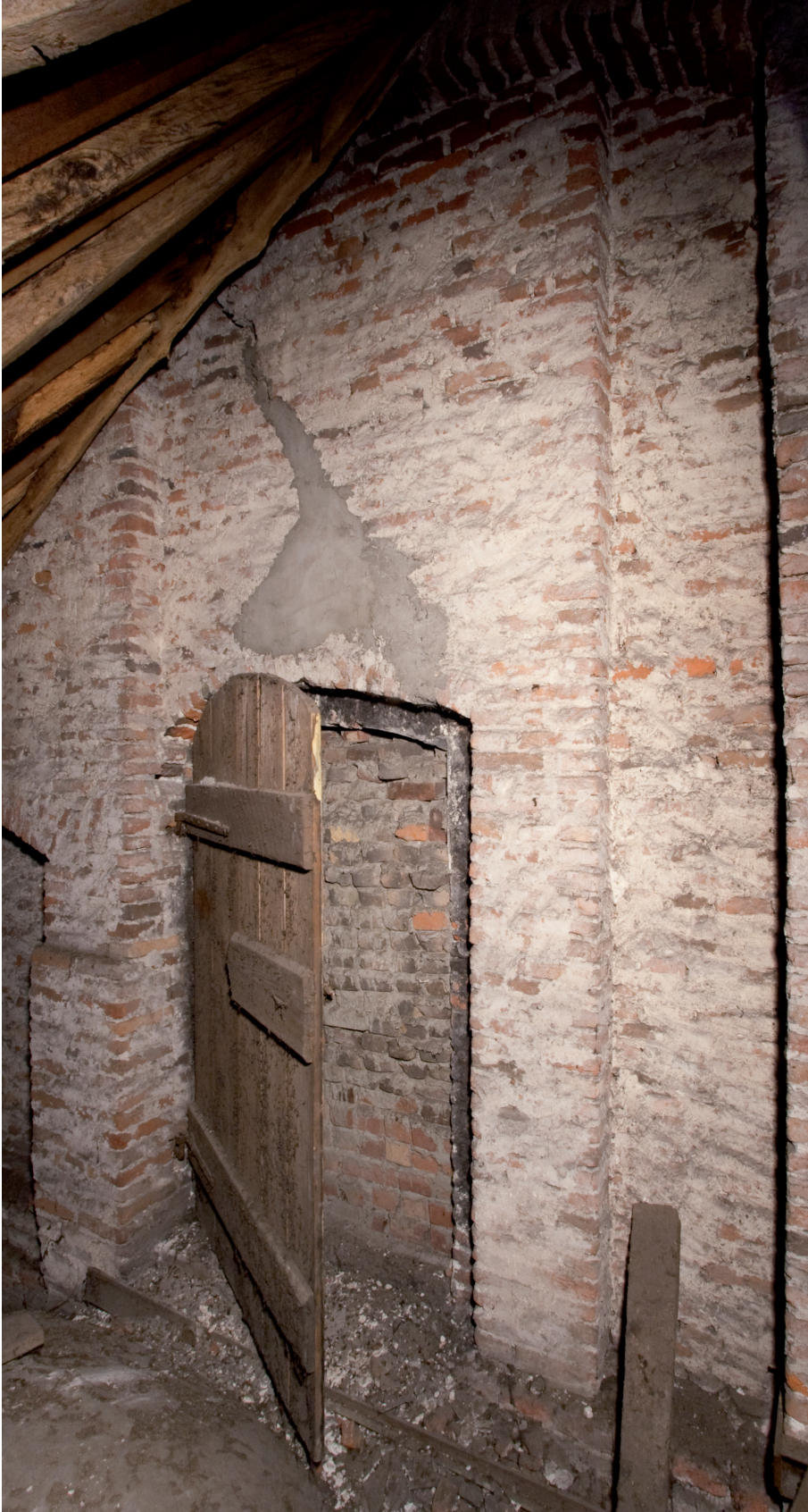
Afbeelding 16: Oorspronkelijke deuropening in de zuidbeuk met een in de negentiende eeuw vervaardigd deurtje.
