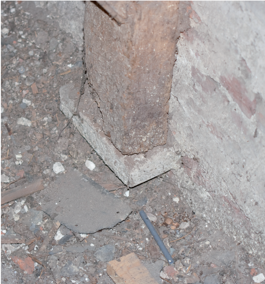
Afbeelding 17b: Op een enkele plek is de muurstijl van de kapconstructie van de zijbeuk nog op een console gezet.
