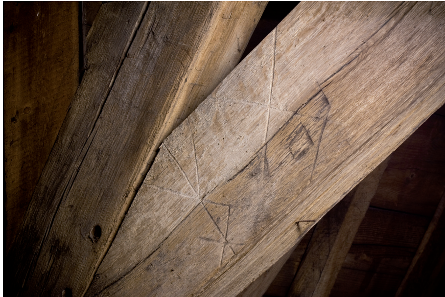
Afbeelding 36: Merken op één van de korbeels van de constructie in de viering. Het betreft vermoedelijk handelsmerken.
