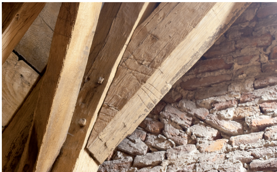
Afbeelding 30b: Het korbeel van het strijkspant in het koor heeft verschillende merktekens, waaronder het telmerk IIII. Het hout is gedisseld.
