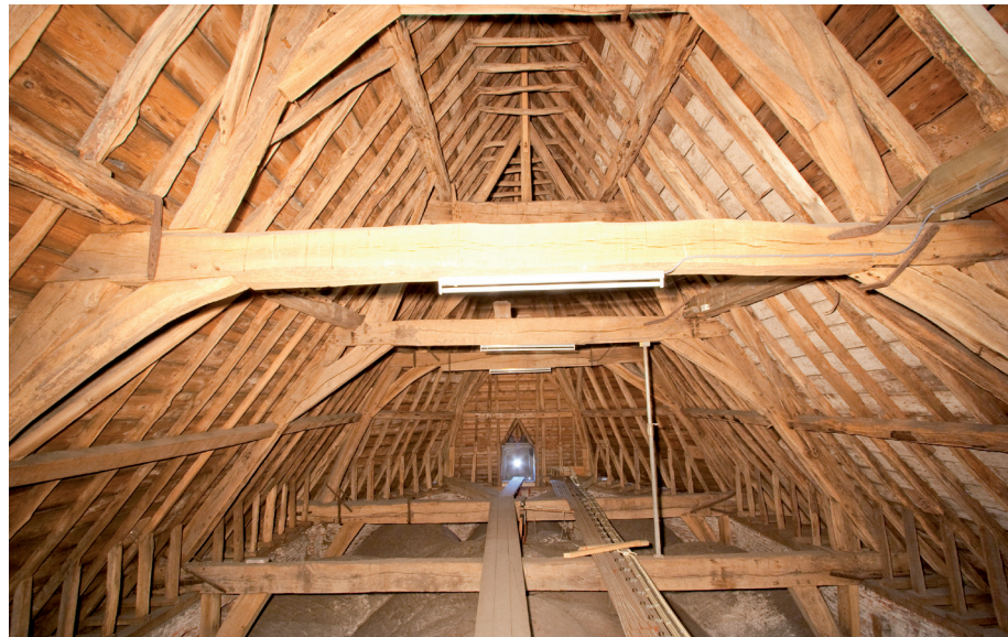
Afbeelding 28: De kapconstructie van het koor, gezien in de richting van de sluiting. Het eerste volledige spant is het spant dat werd gedocumenteerd.
