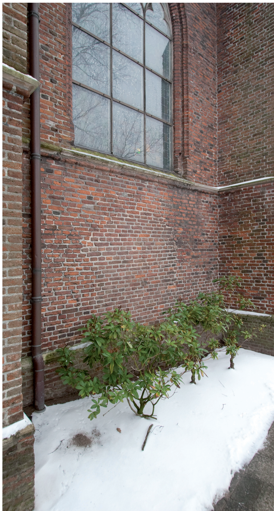
Afbeelding 8: In de tweede travee van de noordbeuk heeft ook een toegang gezeten. Hier treft men echter geen klezoren aan, zodat de oorspronkelijkheid van de toegang niet meer kan worden vastgesteld.
