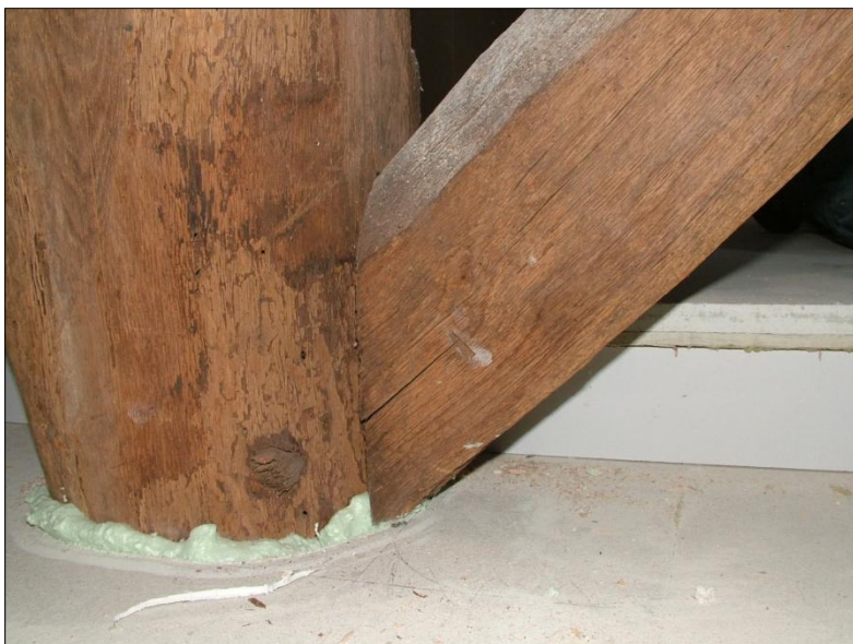
Figuur 13. Merkteken van 1 streep aan gebont I aan de zuid-zijde, buitenkant.
