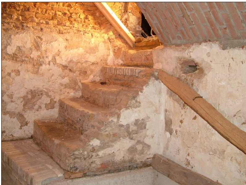
Figuur 10. De trap in kelder 2 van 5 treden. De toog is vernieuwd.
