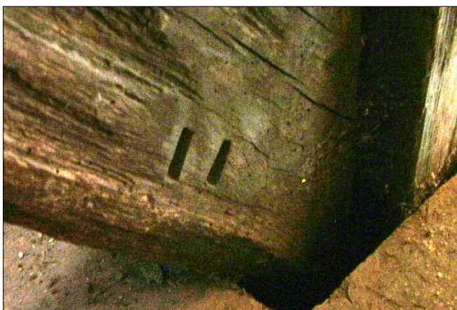
Figuur 14. Merkteken met 2 strepen aan gebont II aan de zuidzijde, buitenkant.
