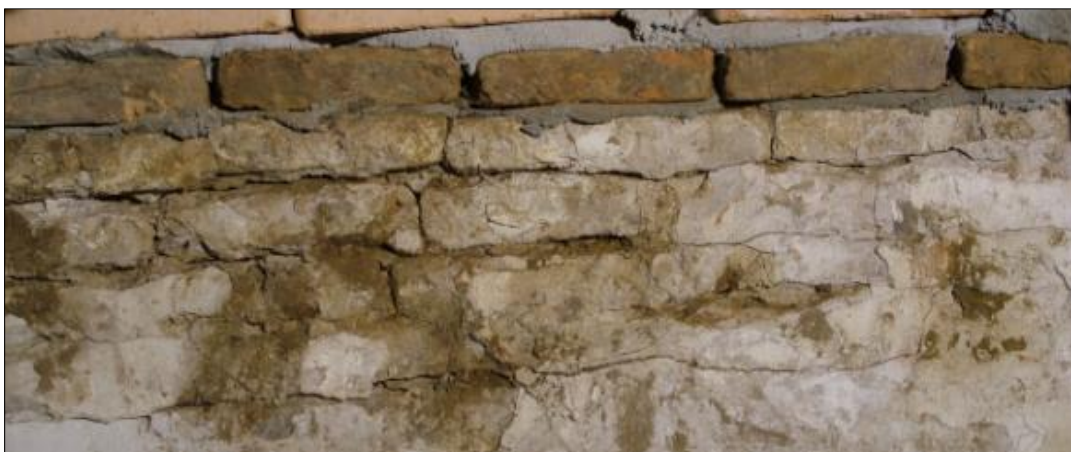
Figuur 11. De ijsselstenen in de noordelijke wand van kelder 2.
