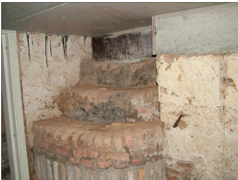
Figuur 9. De trap in kelder 1 van 3 treden. De onderste laag stenen hoort bij de recente verbouwing (waarbij de kelders werden verdiept), evenals het kozijn links.
