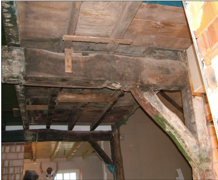
Figuur 18. De gebonten I en II gezien vanaf de schouw (vooraan de moerbalk boven de schouw in de herd). In de zolder zijn de oorspronkelijke eiken kinderbintjes te zien. In het achterste gedeelte de eiken kinderbinten van de uitbouw in 1859.
