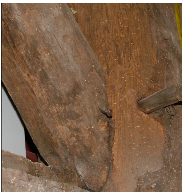
Figuur 15. Merkteken van 3 rondjes aan gebont II aan de noordzijde, buitenkant.
