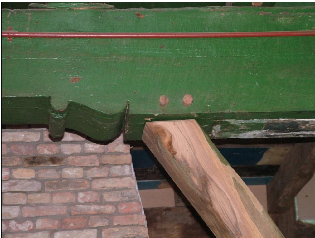
Figuur 17. De moerbalk van gebont II aan de zuidzijde, vanaf de voorkant gezien. De in het verleden verwijderde schoor is weer teruggeplaatst.
